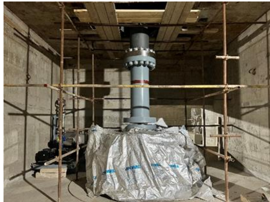
Установка основных насосных агрегатов № 5, 6, 7 и 8 (АБИСРП 01)
