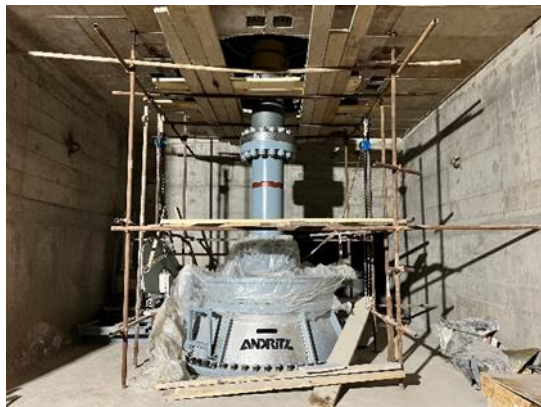
Установка основных насосных агрегатов (АБИСРП 01)
