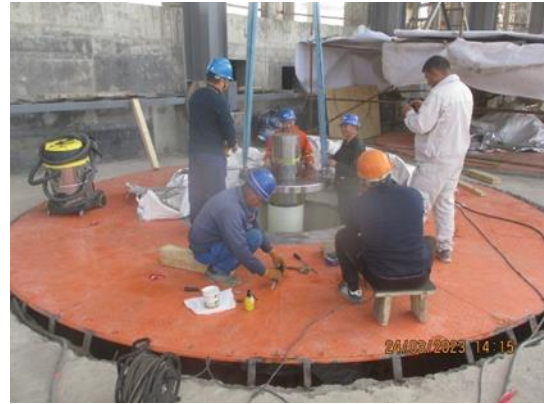
Установка основных насосных агрегатов (АБИСРП 01)
