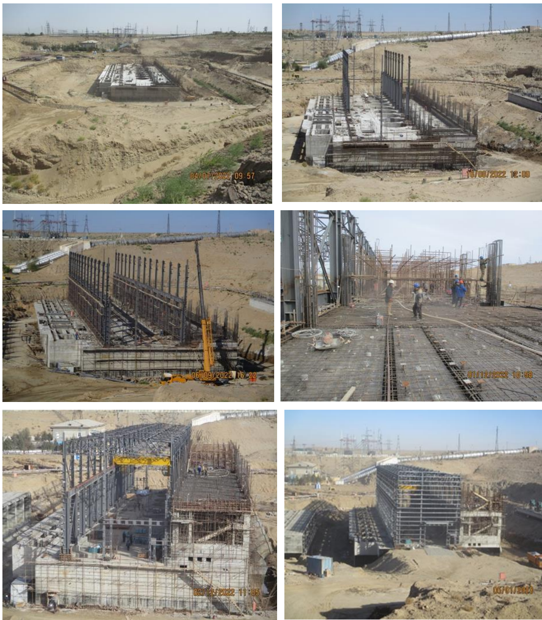
Работы по строительству надземной части (надстройки) здания насосной станции (АБИСРП 01)
